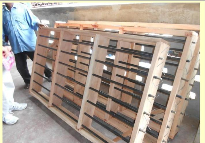
Les châssis de fenêtre sont réalisés sur place rapidement.
